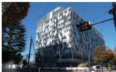
建設中の中野区役所新庁舎
