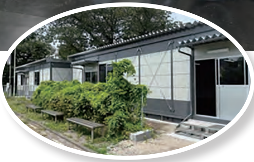
作業場（旧沼袋小学校校庭北側）
